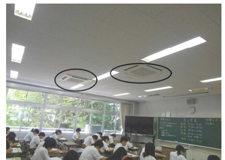
エアコンが天井埋込型で2台ずつ設置
